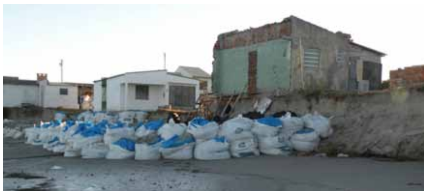
Figura 3: Erosão no balneário do Hermenegildo, Rio Grande-RS.
