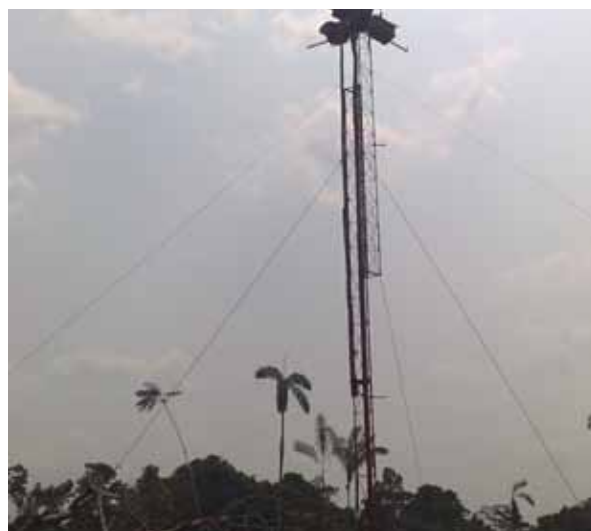
Figura 4: Vista geral da torre instalada com equipamentos para amostragem de gases e particulados no Campo durante a combustão de biomassa.
