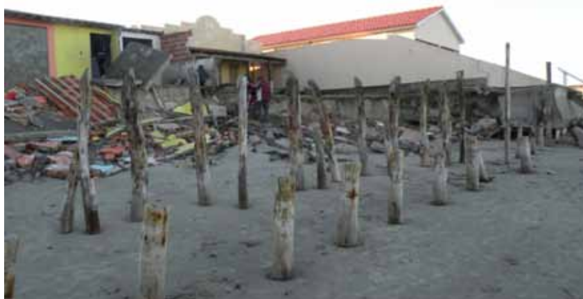
Figura 2: Erosão no balneário do Hermenegildo, Rio Grande-RS.
