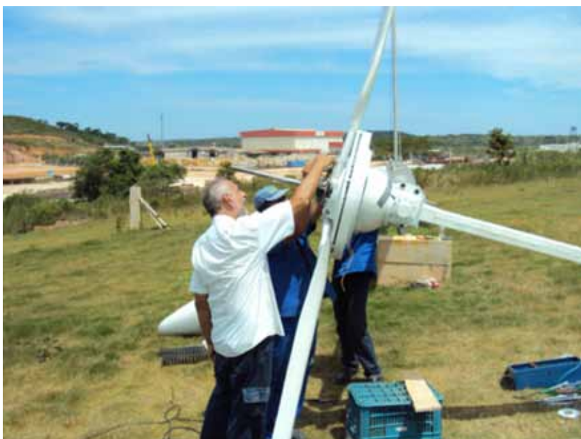
Figura 2: Flagrante da instalação do aerogerador de 6 kW, desenvolvido pelo projeto UENF/ENERSUD, com financiamento da FAPERJ 2019/2011.
