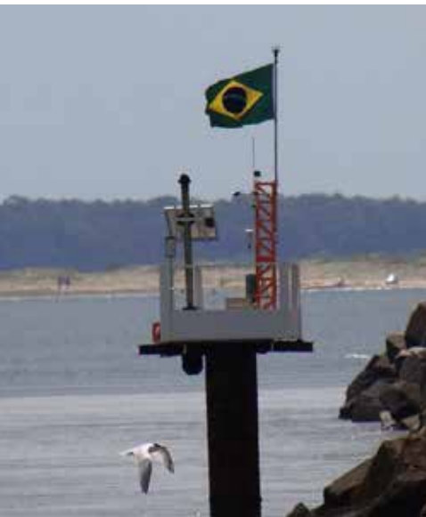
Figura 2: Primeira Estação Marégrafica do SIMCosta, instalada nos Molhes da Barrado Rio Grande (RS).
