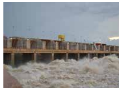
Figura 3 – Vertedouro da UHE de Jirau, Rondônia.
